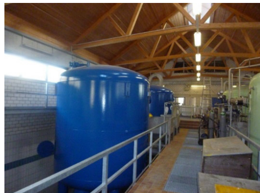
1. Filterstraße nach der Sanierung
