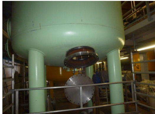
Filter während der Sanierung mit neuem Mannloch
