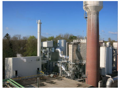
Fernwärmanlage Vorderansicht - Werksgelände Saint-Gobain Oberland AG Quelle: Saint-Gobain Oberland AG
