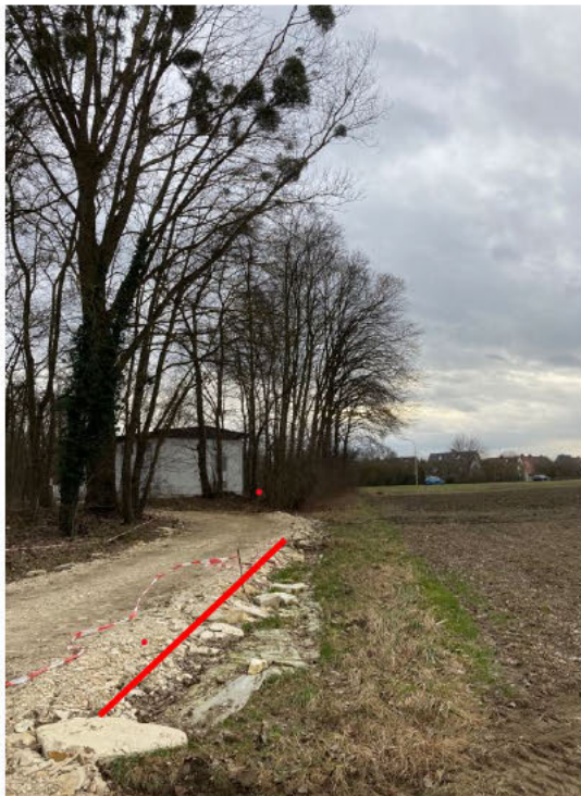
Ansicht zur Bauseite
