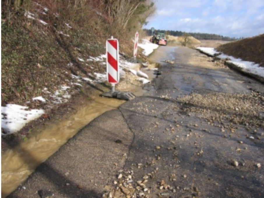
erste Maßnahmen nach starken Regenfällen während des Winters
