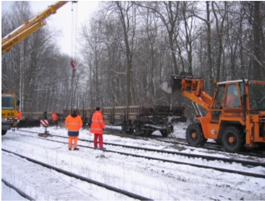
Arbeiten am Industriegleis
