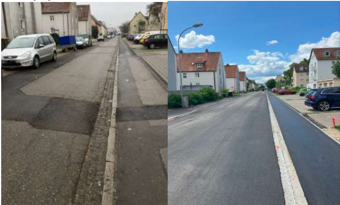
Ertüchtigung der Straße „Am Neufeld“
