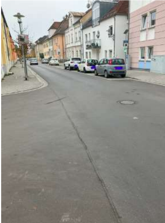
Deckensanierung der Eybstraße
