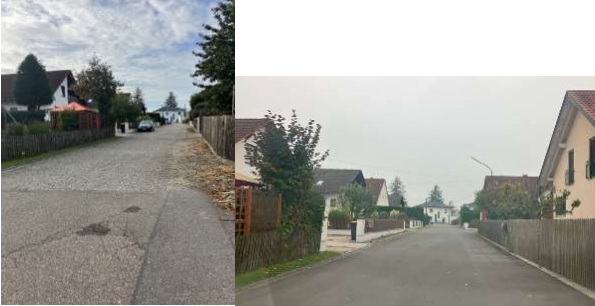
Ertüchtigung der Straße „Am Gromet“ in Marienheim
