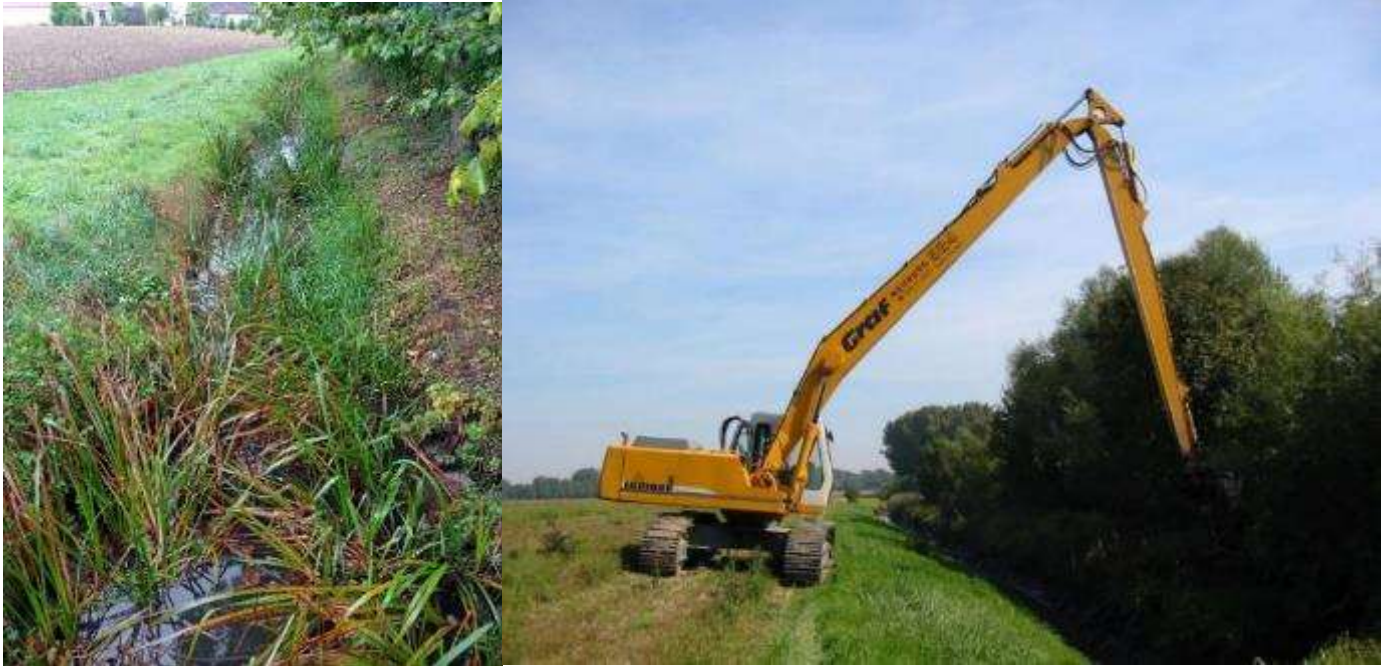
Grabenräumung am Zeller Kanal
