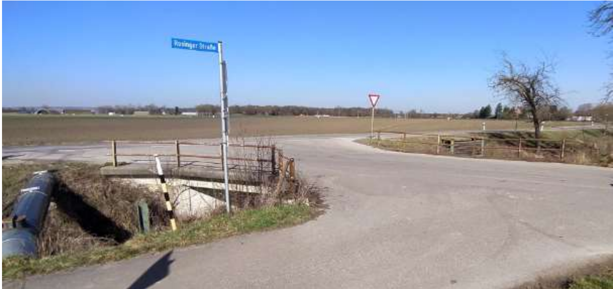
Brückensanierung Rosinger Straße in Zell
