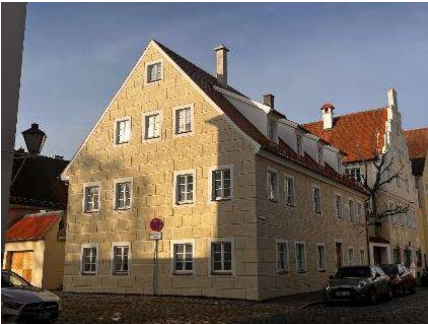
In der Herrenstraße ist ein Gebäude saniert und fertiggestellt worden, welches sich im Ensemblebereich Obere Stadt befindet. Hier fanden in den letzten Jahren einige Abstimmungstermine mit dem Denkmalschutz statt.
