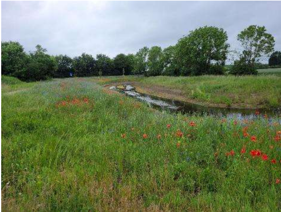
Längenmühlweg 03.06.2024 nach Ansaat und Bepflanzung südl. der Brücke
