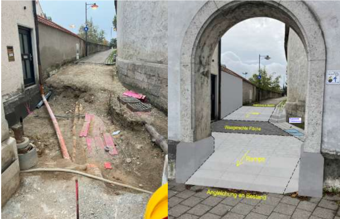
Bau einer stufenlosen Rampe am Dr.-Reiter Weg (zeitnahe Fertigstellung)
