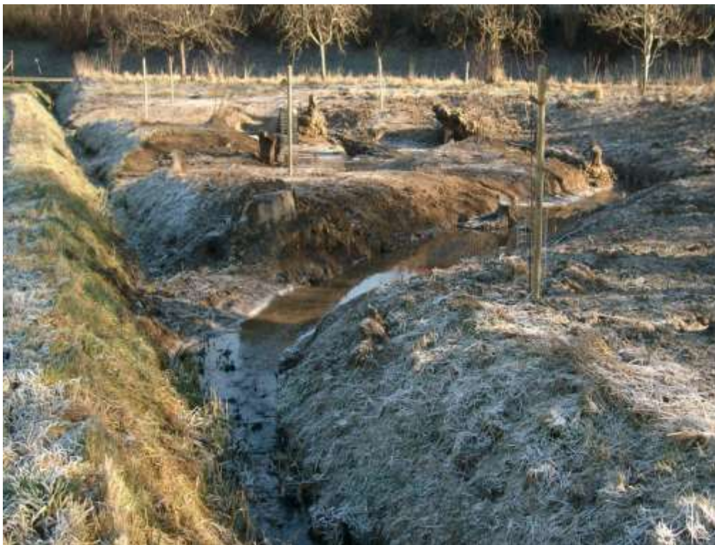
Strukturverbesserung und Uferaufweitung am Lohgraben in Bergen
