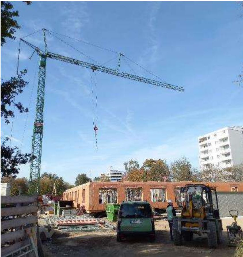
Im Schwalbanger wurde mit dem Bau des neuen Familienzentrums begonnen.
