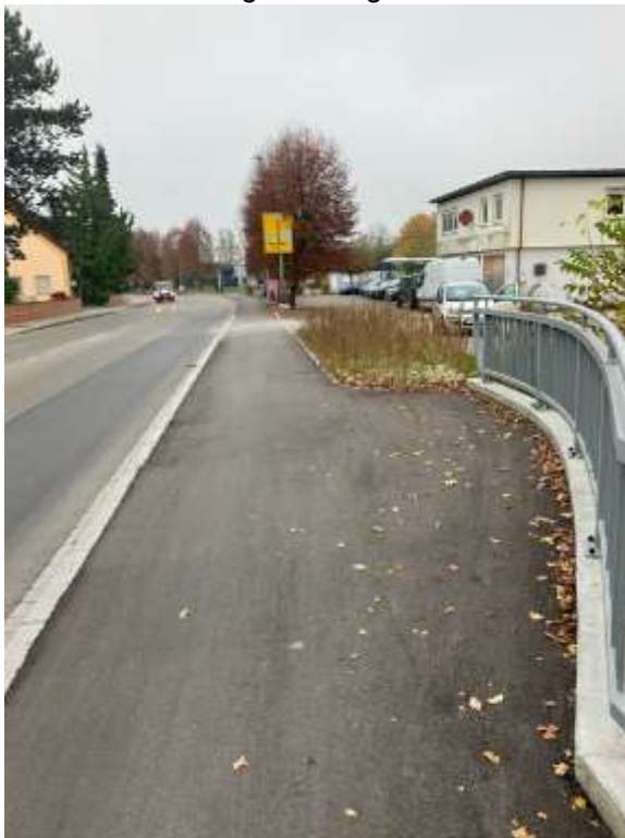
Deckensanierung Gehweg Münchener Straße
