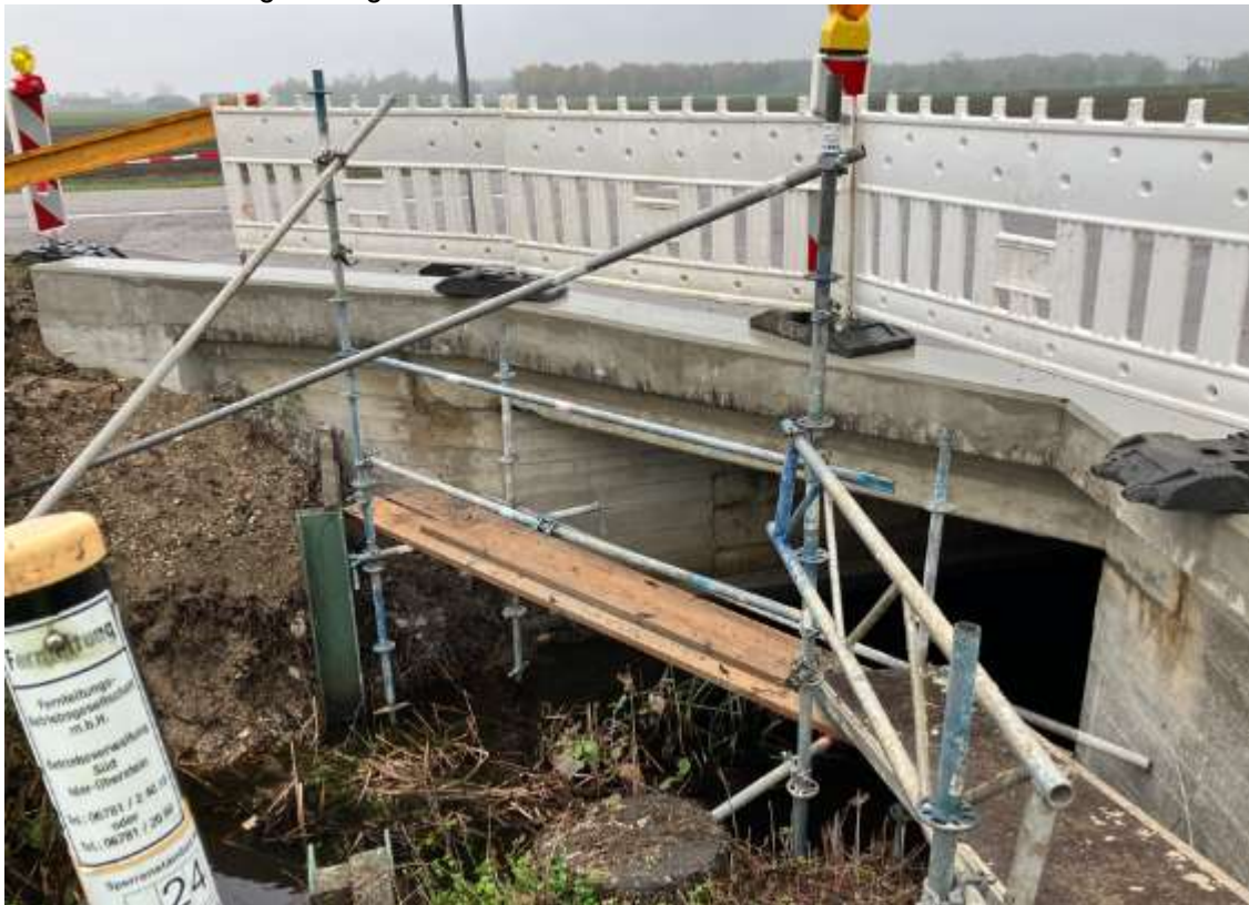
Brückensanierung Rosinger Straße in Zell
