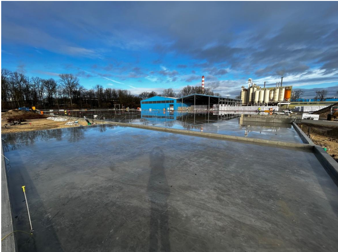
In der Ruhrstraße beginnt die Errichtung eines Hochregallagers, die massive Bodenplatte befindet sich in der Fertigstellung.
