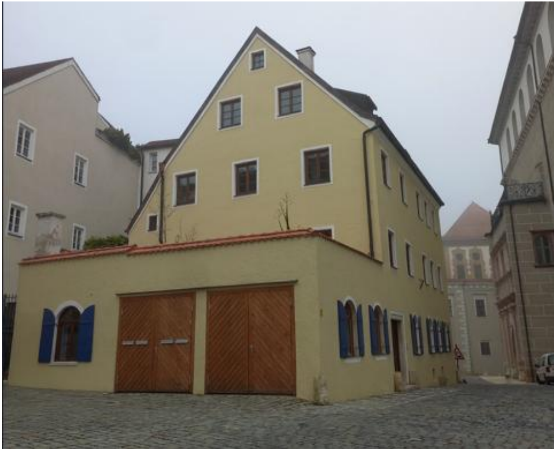
Ein Baudenkmal in der Oberen Altstadt erhält einen neuen Anstrich.
