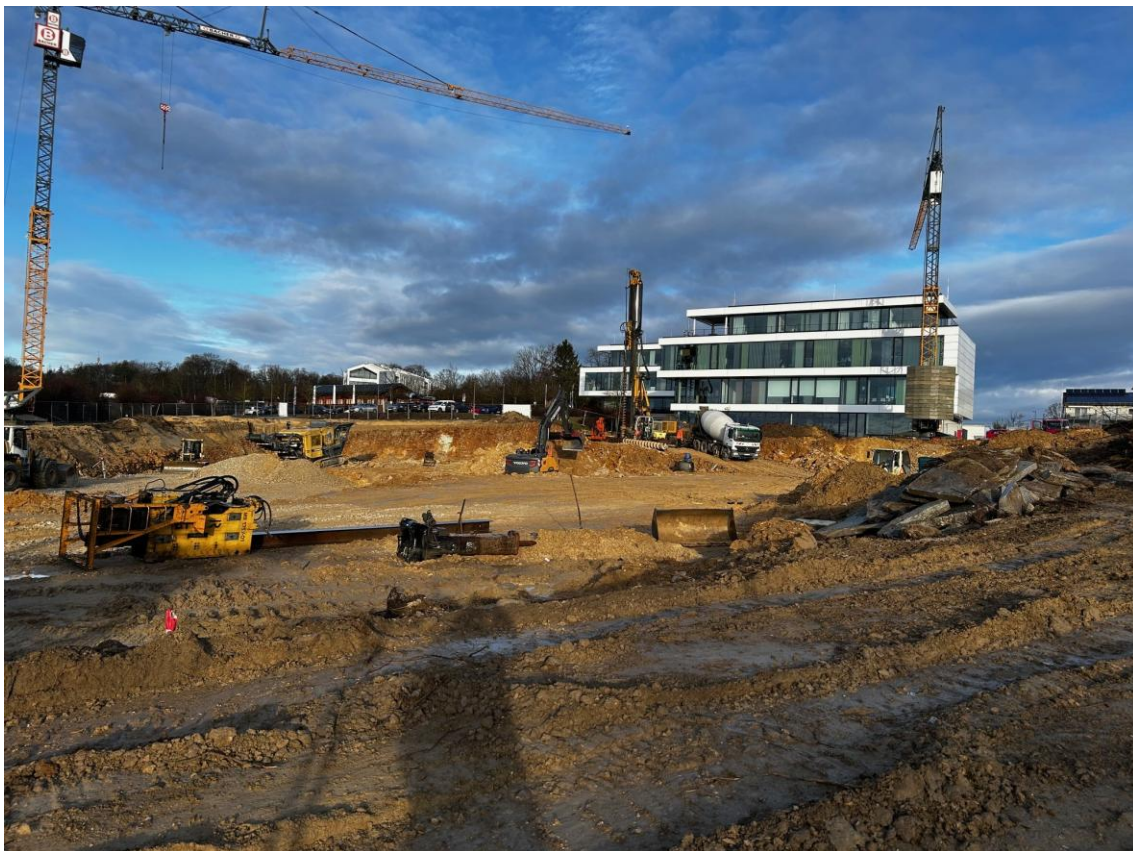
Spatenstich, Baugrubenaushub und Spezialtiefbauarbeiten leiten den Bau eines Büro- und Veranstaltungsgebäudes ein.
