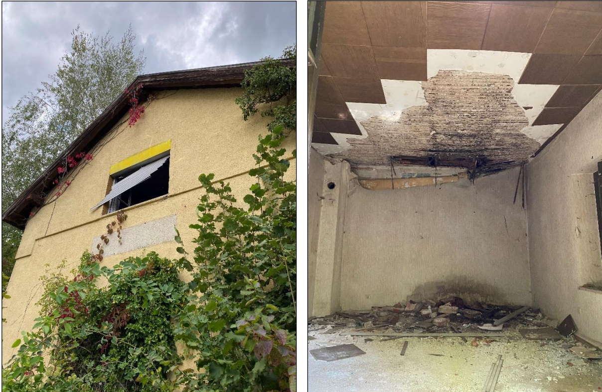
Abbildung 5: links: Haus mit angeleuchteter Ausflugsöffnung zu den Bahngleisen; rechts: Einblick ins Erdgeschoss von der Südwestseite.
