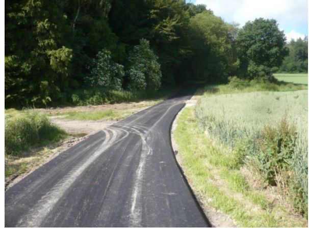
6.a) Straßenunterhalt 2016, OT. Bergen, Forstweg, Planung, Oberbauleitung
