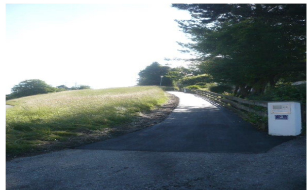
6.e) Ried, Fußweg zur Kapelle, Verbesserungsmaßnahme
