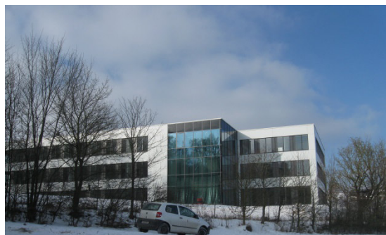
Verwaltungsgebäude der VIB
