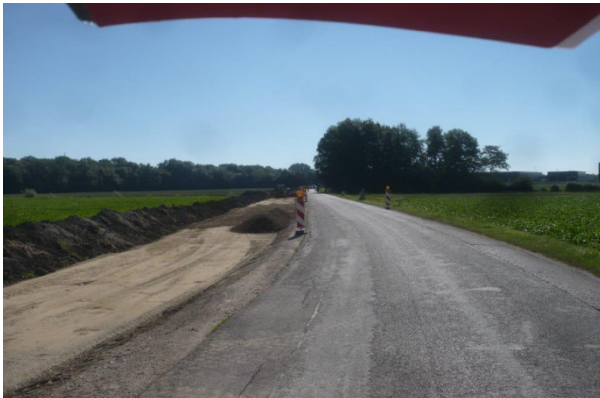
6.b) Heinrichsheimstraße, Verbesserungs- maßnahme, Planung, Ausschreibung, Bauleitung
